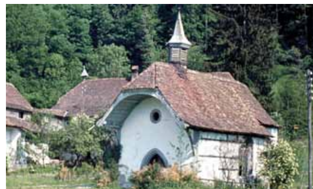
Die geschützte Kapelle von Bad Bonn wurde vor den Fluten gerettet, aber nicht wieder aufgebaut.
